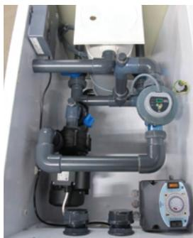
Composto da una cella, un'apposita centralina per l'elettrolizzatore.
